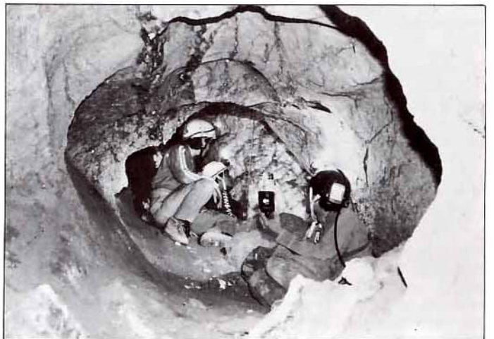
Galería de tipo erosivo-corrosivo
