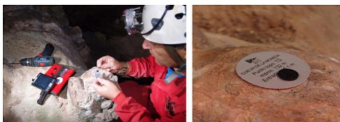
Figura 3. Instalación del punto o marca topográfica Topo Point 41.25.
