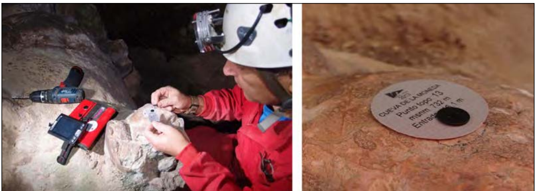
Figura 3. Instalación del punto o marca topográfica Topo Point 41.25 .
