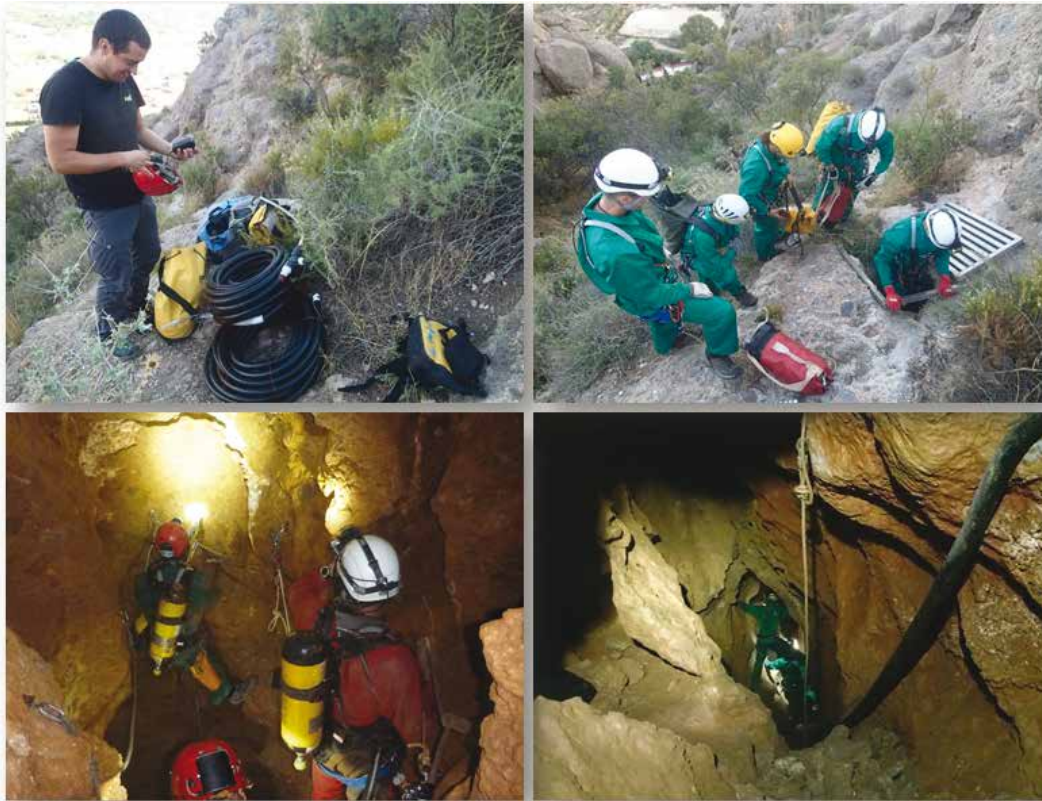
Figura 2. Proceso de instalación de un sistema de muestreo multicanal de aire en la Sima del Vapor tuberías flexibles de PCV, realizado por el Grupo Especial de Rescate en Altura (GERA) perteneciente al Cuerpo de Bomberos de la Comunidad de Madrid.
