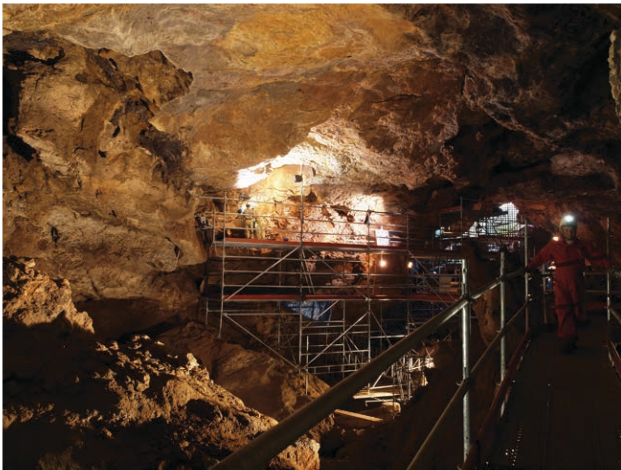
Fig. 5. Andamio instalado en la sala Victoria 1 donde se realizan en la actualidad trabajos de excavaciones paleontológicas en la pared Este.
